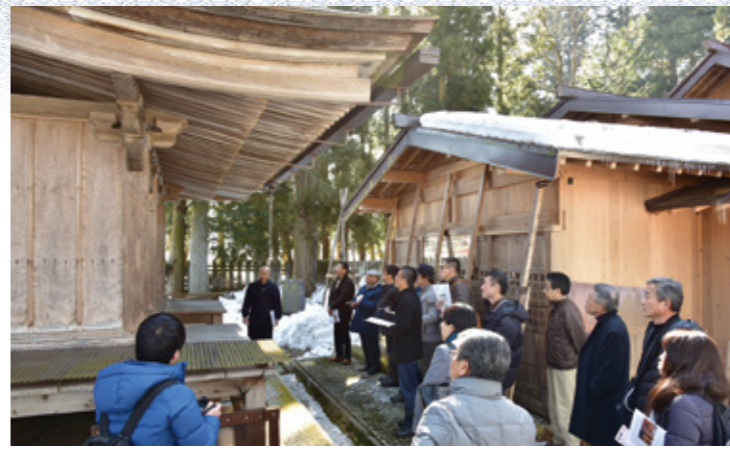
国指定重要文化財「荒城神社本殿」
